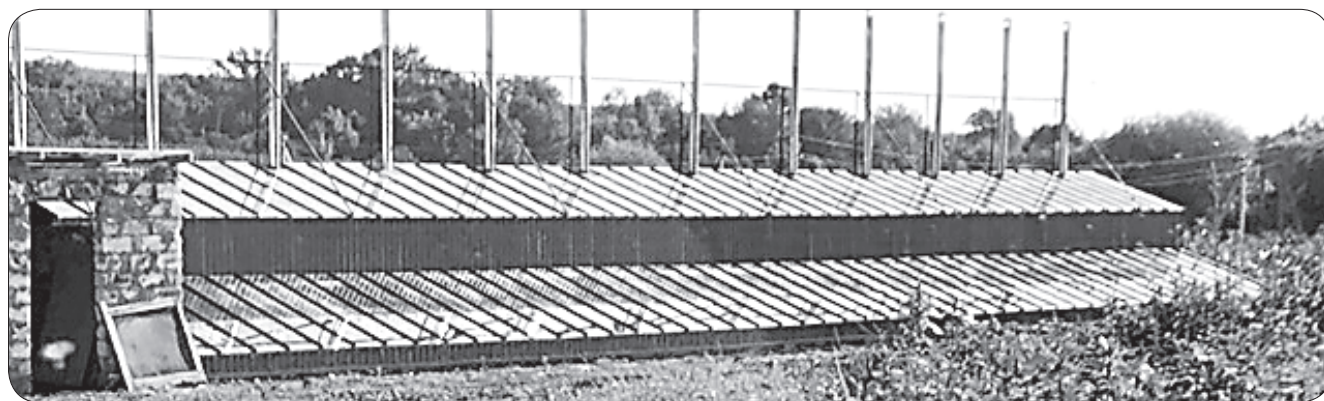
Uscătorie care funcționează exclusiv cu folosirea energiei solare
